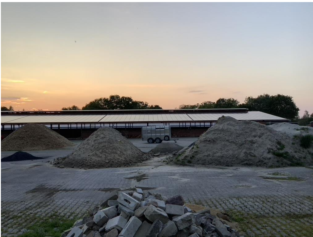
Abbildung 3: Umzubauendes Stallgebäude Seitenansicht
