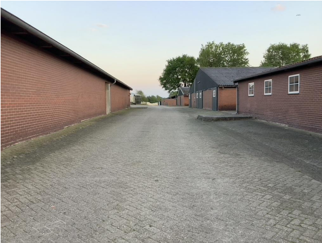
Abbildung 2: Übersicht Stallgebäude vom nördlichen Zugang
