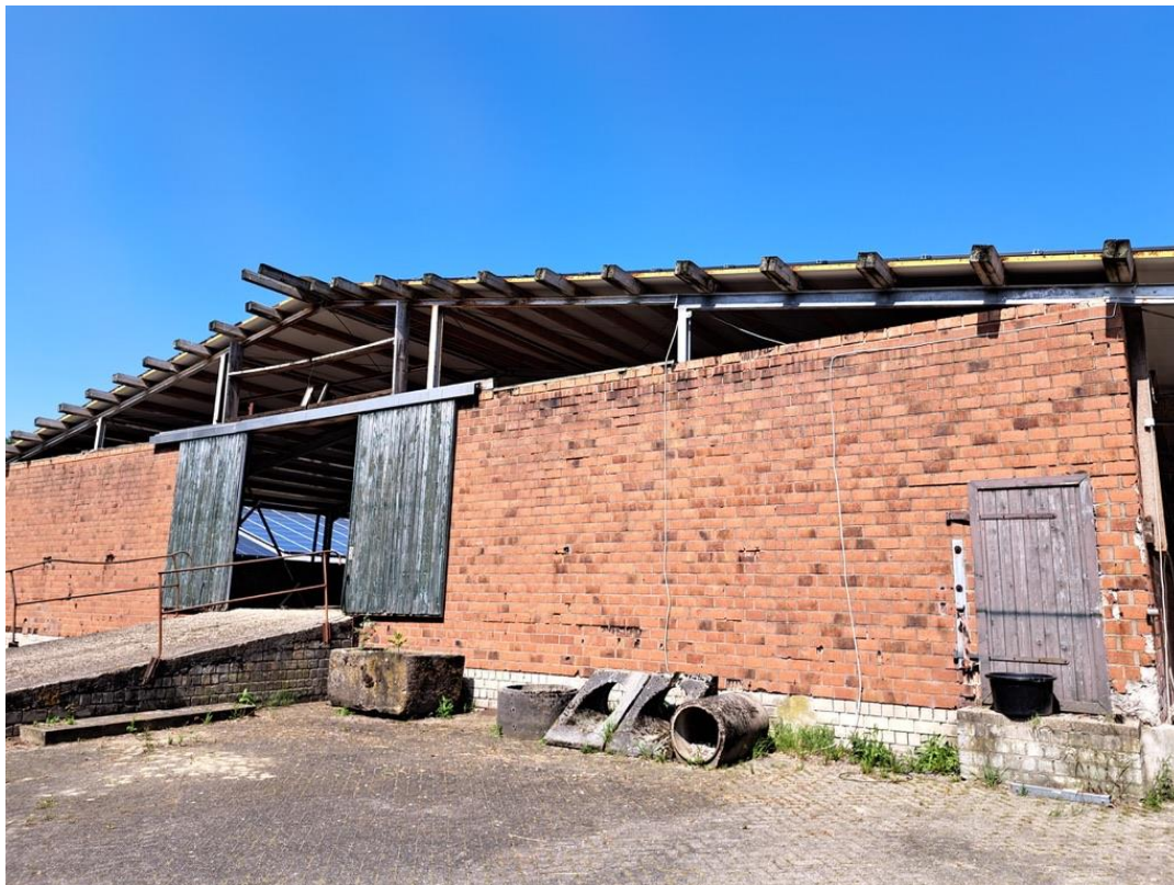
Abbildung 4: Umzubauendes Stallgebäude – Mauerfugen stellen ein geringes Quartierpotenzial für Fledermäuse dar
