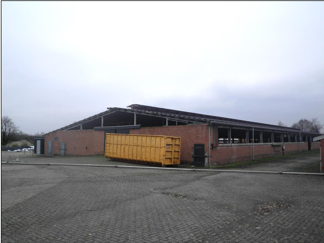
Abbildung 3: Blick auf das konkret von Umbaumaßnahmen betroffene Stallgebäude (14.12.2023).
