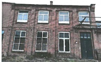
Foto IV und V: Nordseite, intaktes Mauerwerk, unter dem Dachvorsprung keine Spuren von Vögeln
