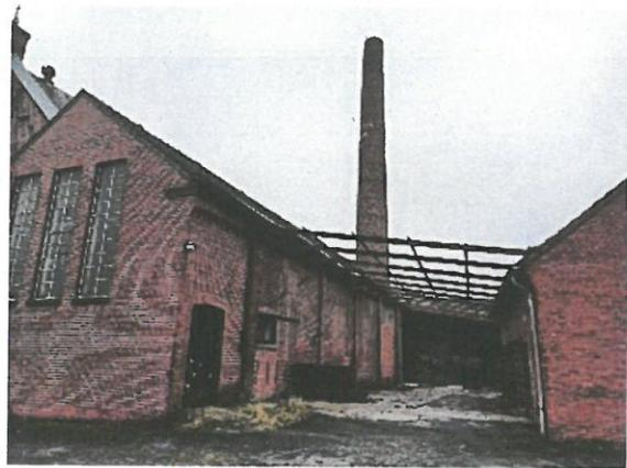
Foto VII: kleine Halle an der Westseite, vom Umbau/Abbruch nicht berührt, hinten Schornstein, Öffnungen in Bodennähe zugemauert
