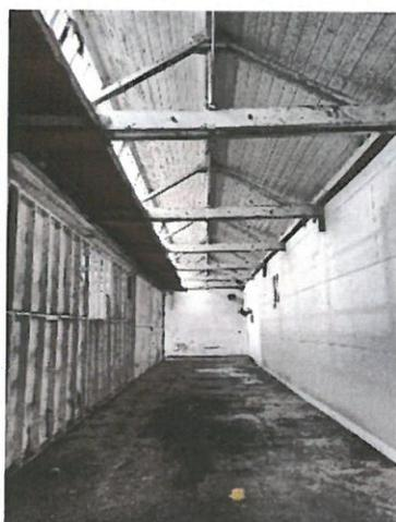
Foto XI – XIII: typischer Hallenaspekt, glatte Wände, lichtdurchfluteter Raum, Eisenträger, glatt Verschlussene Decke unter der Dachdeckung
