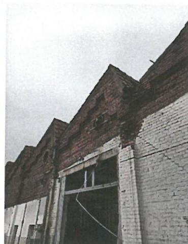
Foto VIII – X: rückwärtige Ansicht, Abbrucharbeiten begonnen, Blick von Seite auf das Sägezahndach (Sheddach)
