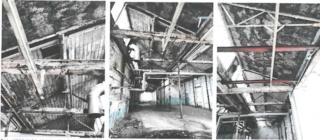
Foto XXXVII bis XXXIX: Bretter von unten abgetragen, Heraklitplatten sichtbar, Abdeckung aufgebrochen
